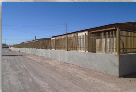
**Reposición Cierre Perimetral Piscina:** Se consulta reposición de muro perimetral, considerando 50 Ml., aproximadamente de muro en perfil metálico y muro de hormigón (Muro Mixto).
