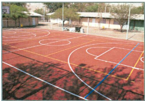
La instalación de piso del tipo decoflex - polieritano, en multicancha. Esc. G-15 de localidad de Quillagua. La superficie es de aproximadamente 620 m<sup>2</sup>.
